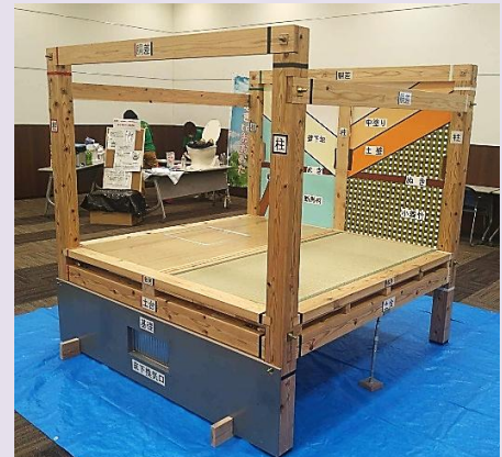
図3 床下浸水対応講習会用模型
